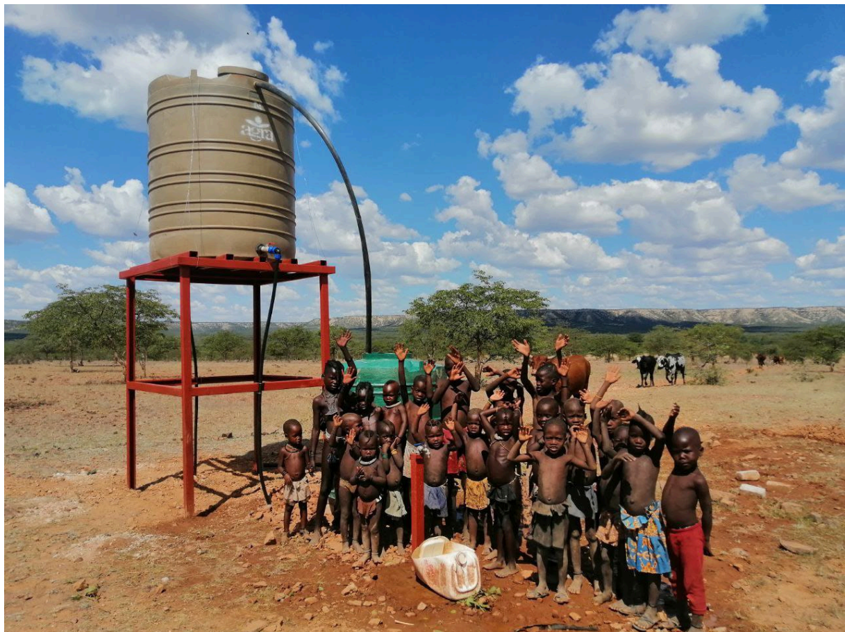
Bildtitel: Solar-Brunnenpumpe für Wasserversorgung an der Schule Bild: Andreas Horn, Kaokoland e.V.
